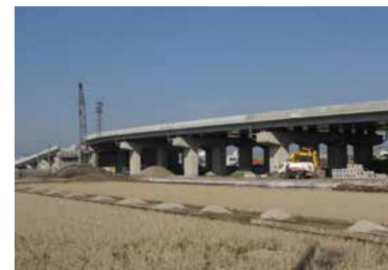
工事が進む七美太閤山線
